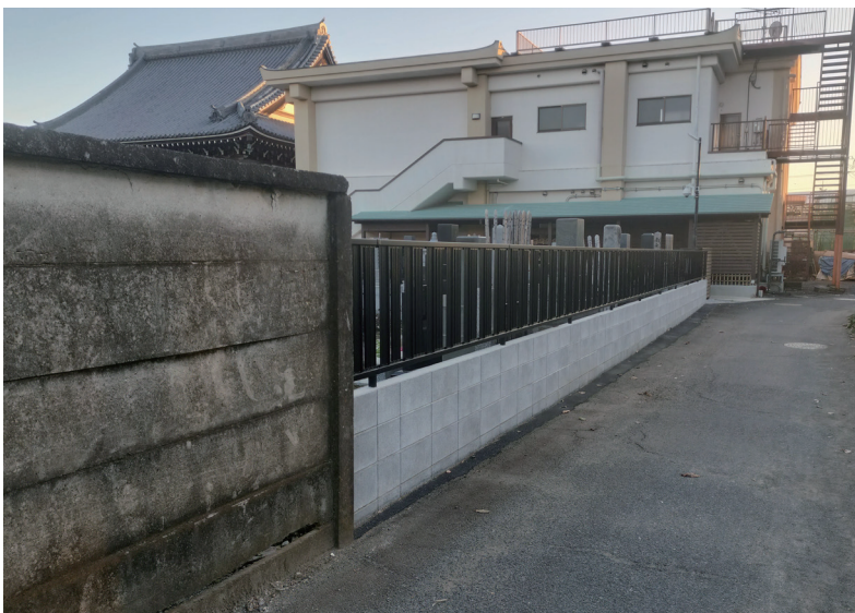
新しいフェンス／手前(左側)は古い万年塀
